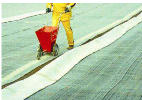
Soudure du GSB à la bentonite
