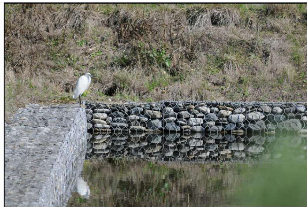
Exemple de traitement de talus de bassins en pentes fortes ou gabions
