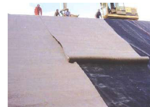
Mise en place du géotextile sur la géomembrane
