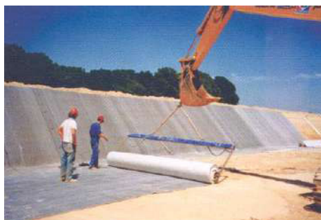
Pose des rouleaux de membrane en GSB
