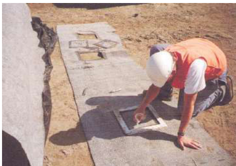
Test de contrôle in situ de la qualité du géotextile synthétique bentonitique (GSB)
