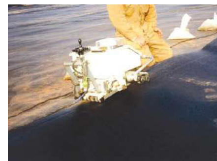
Mise en place de la géomembrane double soudure à canal central
