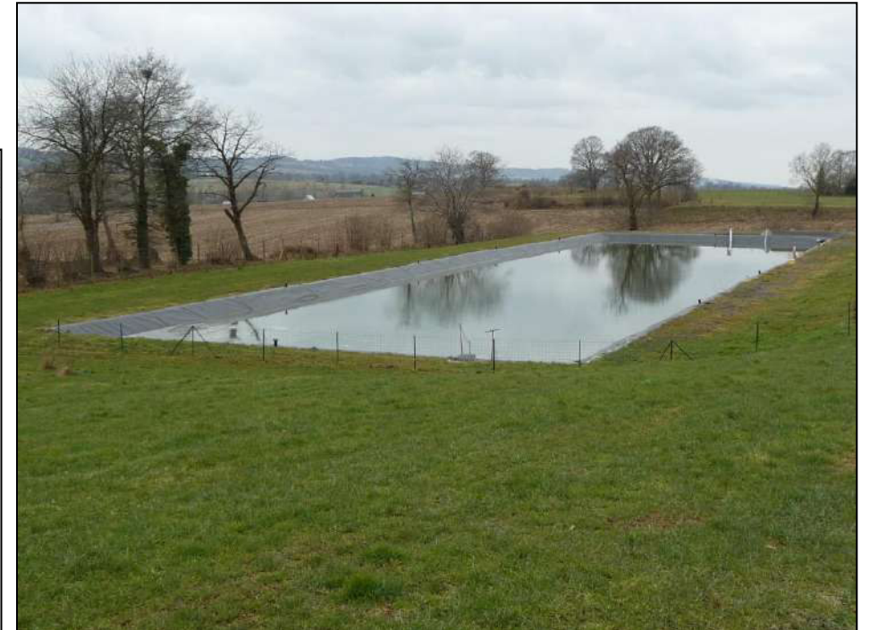
Exemple de bassin d'eaux pluviales
